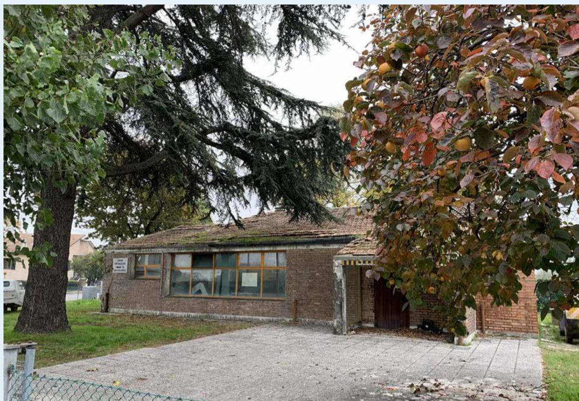
Veduta esterna della scuola del Bornaccino
