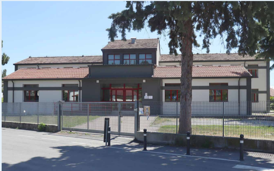
La palazzina A della scuola media ex Saffi
